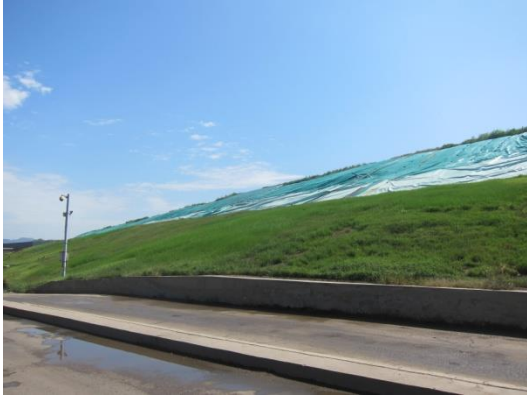
阿苏卫垃圾卫生填埋场现状照片
